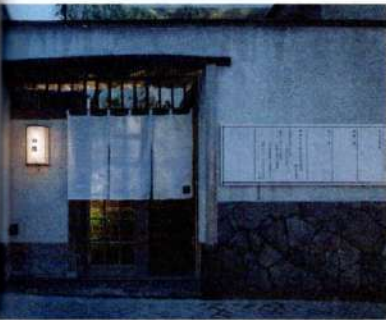
TRUNK(HOUSE)の外観。かつて料亭の名前であった「山路」の名前はそのまま残している
